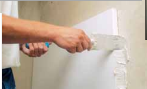
Kleber an Kanten aufbringen
